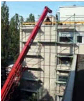
Abb. 1: Bau der neuen Kältezentrale
