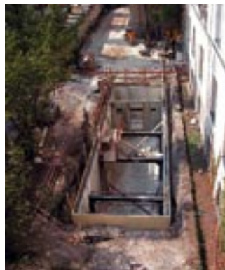
Abb. 2: Bau der unterirdischen Stromverteilerstelle
