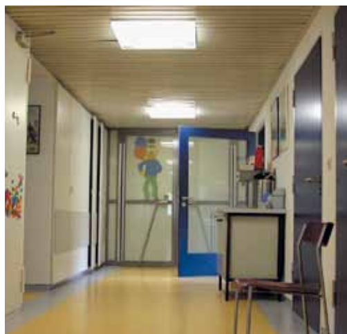
Abb.3: Flur der renovierten Station Chirurgie 1 (Privatstation)
