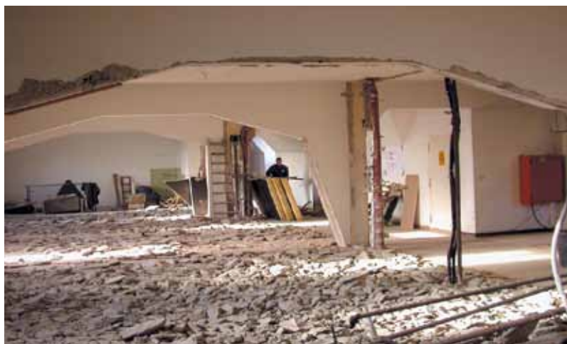
Abb.1: eingerüsteter Westflügel des Gebäudes Lindwurmstr. 2a mit der Baustelle im Dachgeschoß für das Hope-Center
