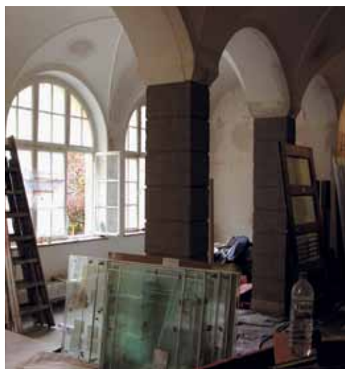
Abb.5: Baustelle im Erdgeschoß Altbau. Wieder freigelegte alte Eingangshalle
