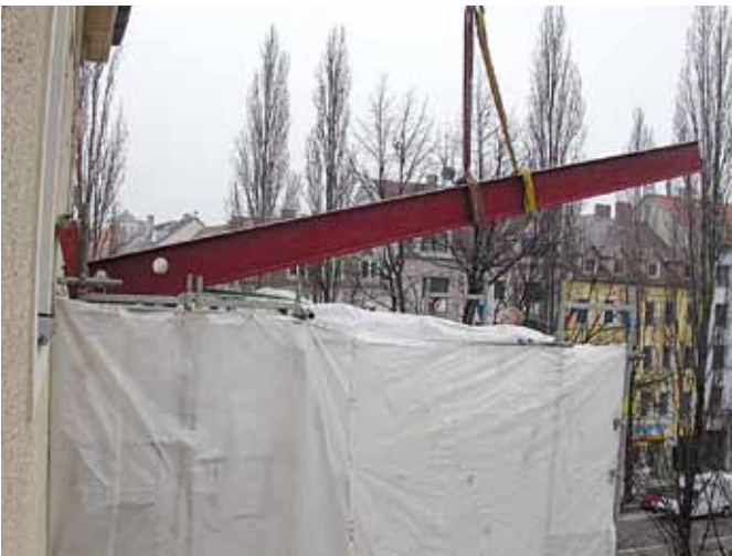
3 Einbringen von Stahlträgern zur Deckenverstärkung Lindwurmstr. 2a
