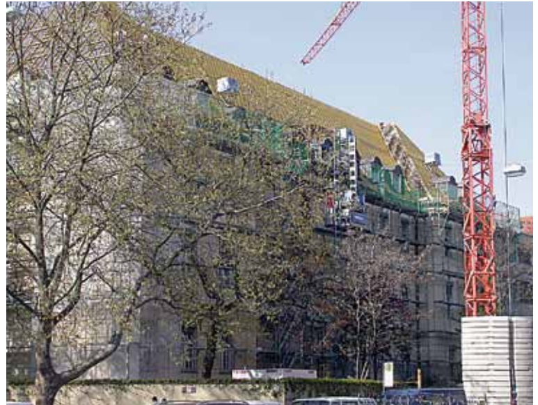
2 Einbau neuer Gauben nach alten Plänen und Erneuerung des Daches
