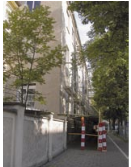
3 Aufbau der Gerüste Goethestr. für die Sanierung der Station Intern 5
